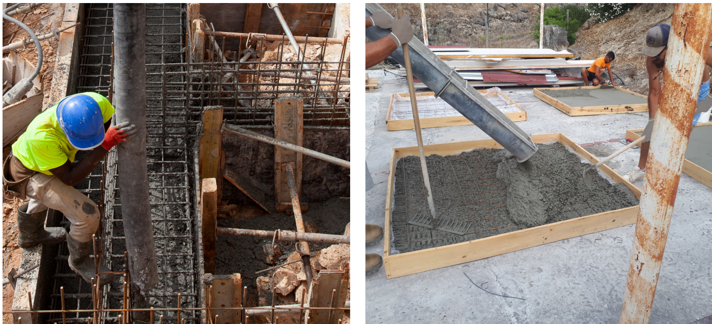
Fig. 3 - Exemplos de utilização de Betão na execução de enchimento de estruturas.
